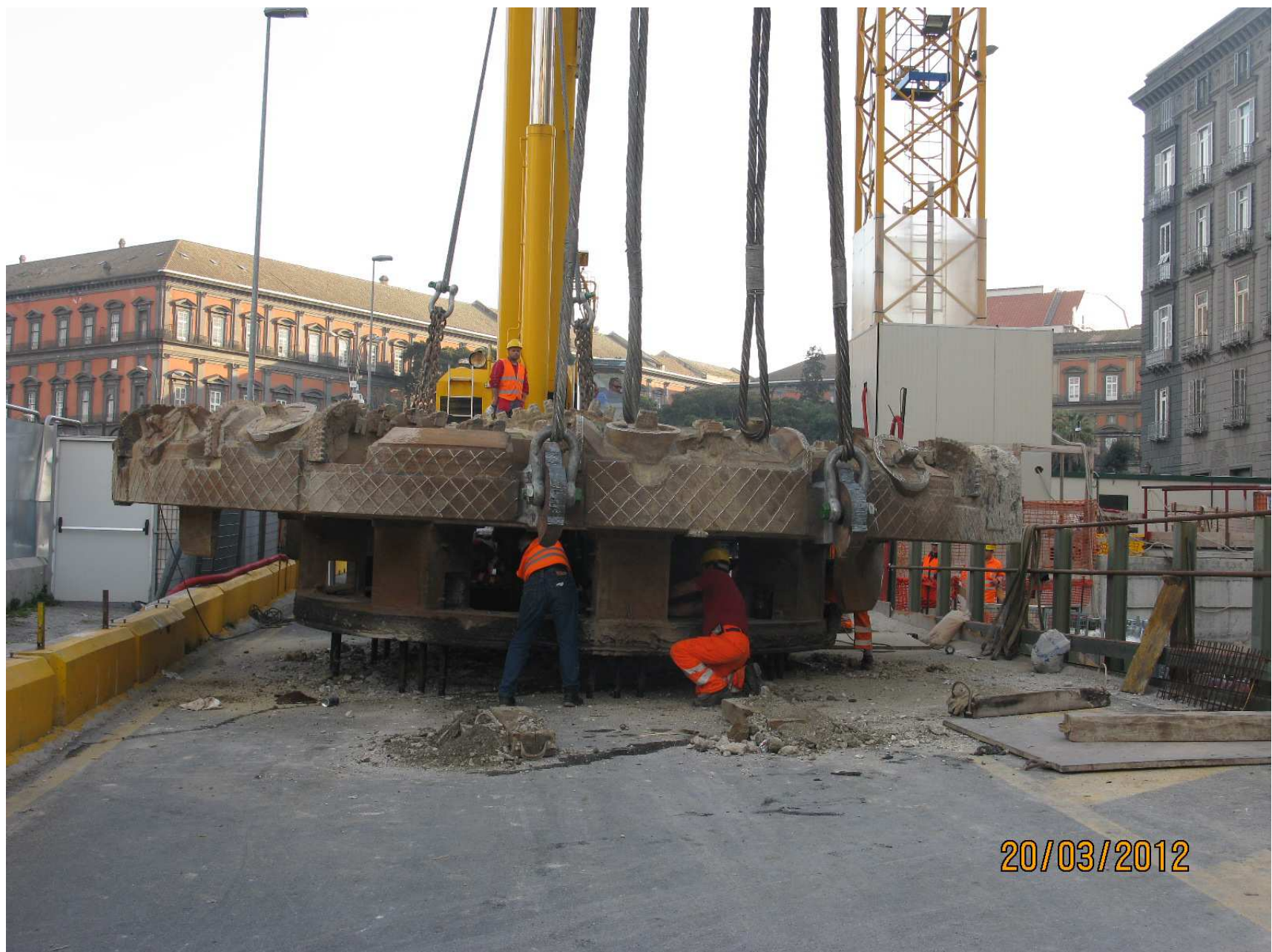
Pozzo di estrazione della TBM a Municipio
