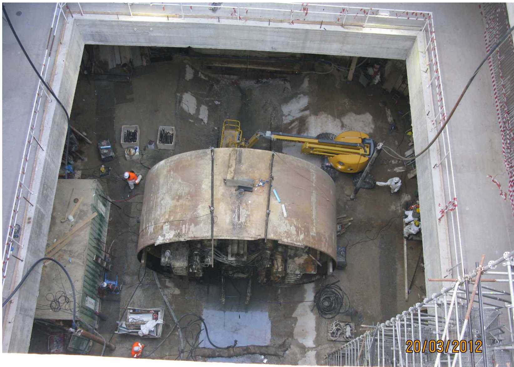
Pozzo di estrazione della TBM a Municipio Elemento anteriore da estrarre ( peso c.a. 260 tonn. )
