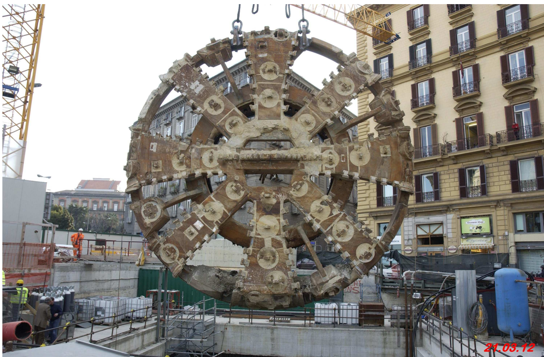
Pozzo di estrazione della TBM a Municipio In corso l' estrazione della testa fresante
