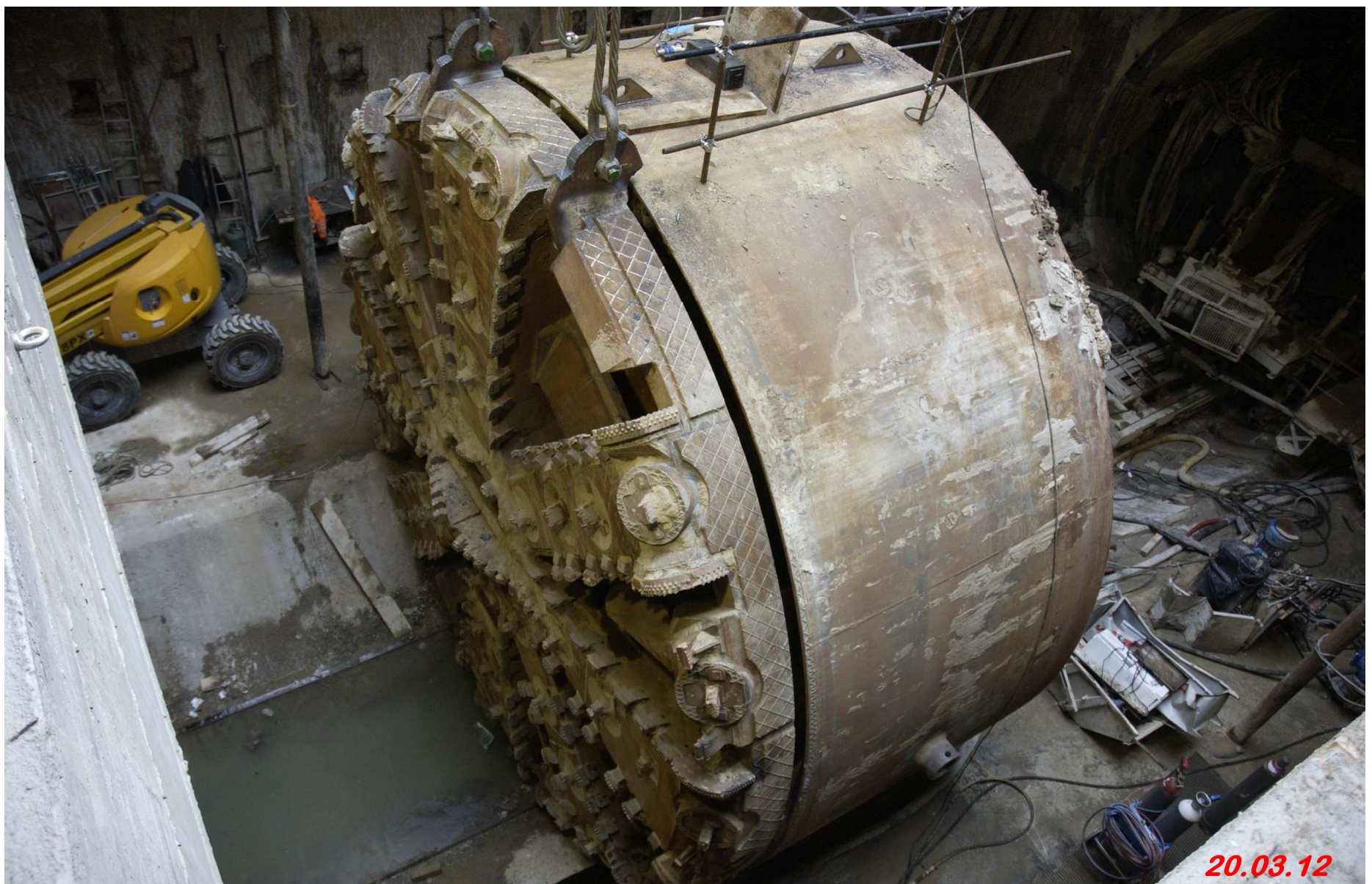
Pozzo di estrazione della TBM a Municipio Imbracata la testa fresante è in corso lo scollegamento dall'elemento intermedio
