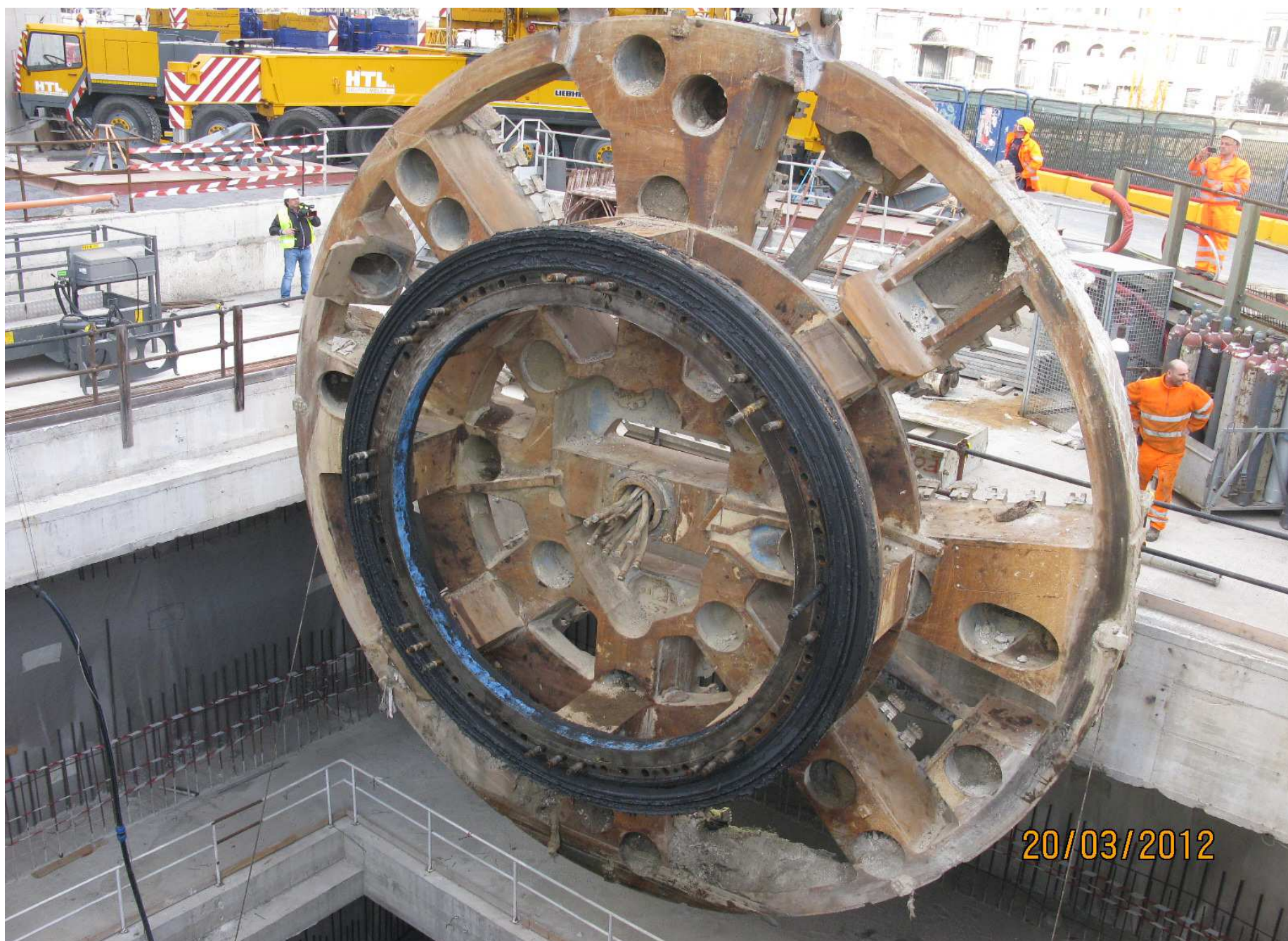
Pozzo di estrazione della TBM a Municipio In corso l' estrazione della testa fresante
