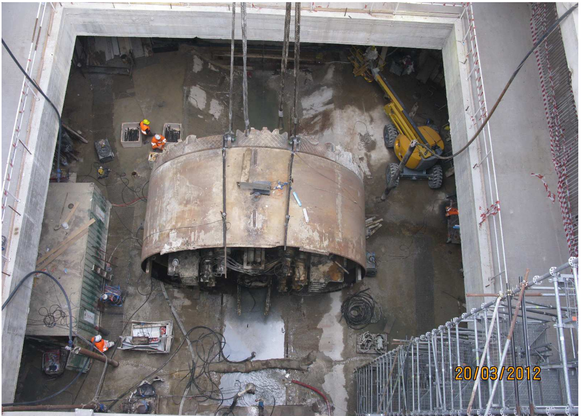
Pozzo di estrazione della TBM a Municipio Imbracata la testa fresante è in corso lo scollegamento dall'elemento intermedio
