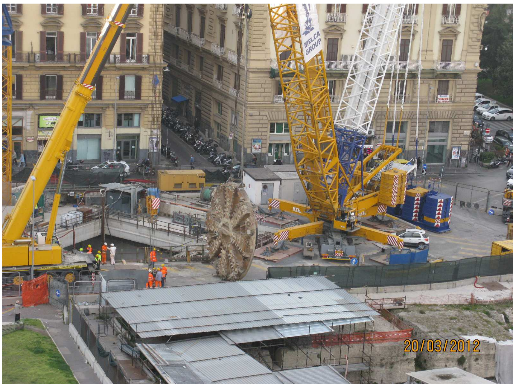
Pozzo di estrazione della TBM a Municipio Ultimata l' estrazione della testa fresante
