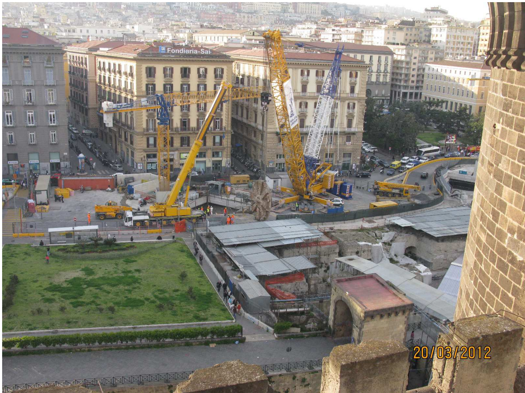
Pozzo di estrazione della TBM a Municipio Ultimata l' estrazione della testa fresante
