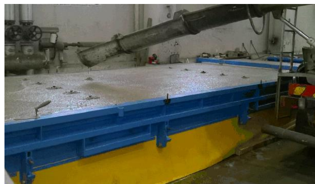
Fabbricazione di un elemento di impalcato Bétonnage d'un élément de dalle
