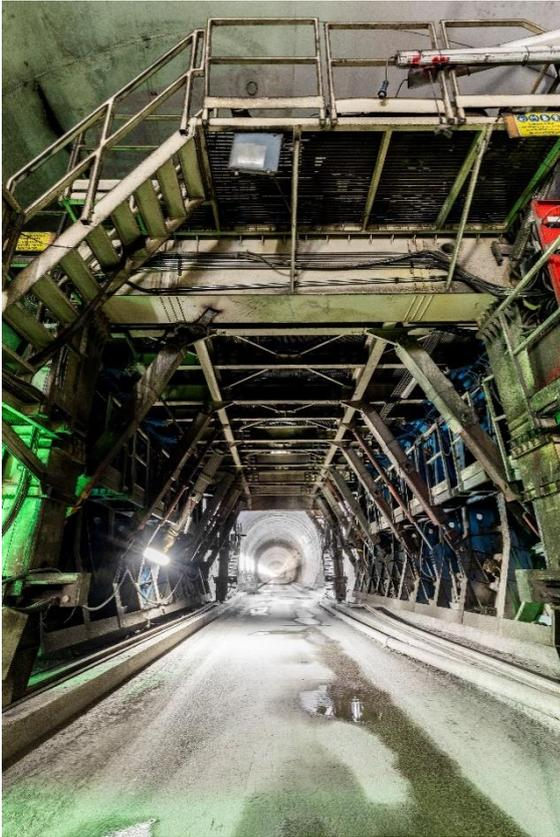
Lo **scavo tradizionale**, con successivo consolidamento in calcestruzzo proiettato, rappresenta un metodo di scavo flessibile, che si rivela molto efficace in presenza di ammassi rocciosi instabili e mutevoli e in caso di geometrie delle sezioni di dimensioni variabili e complesse. Il metodo consente un avanzamento medio di 5-8 m/gg.
